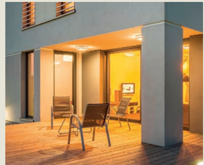
Abitazioni prefabbricate in legno Prefabricated homes Wood
