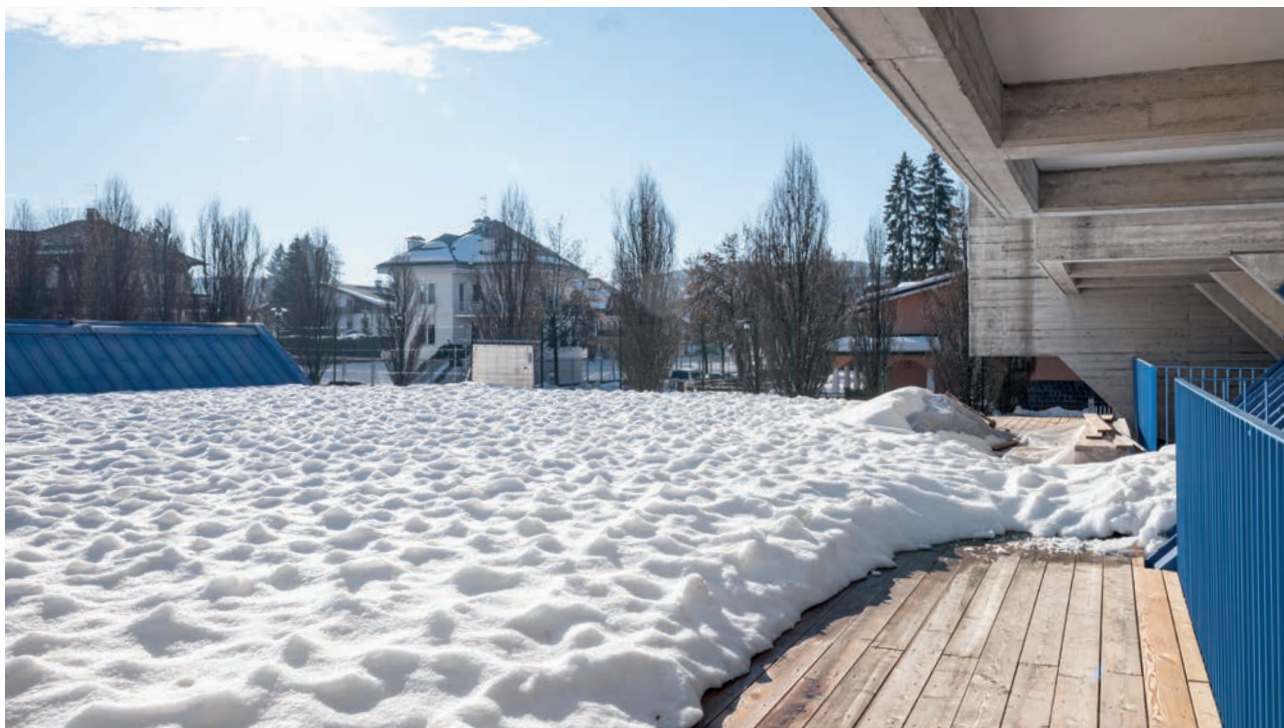
Istituto Comprensivo Statale – Rooftop, terrazze Asiago (VI), Italia Woodeck System – New Maxi NM
